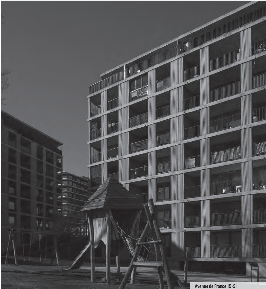
Avenue de France 19-21
