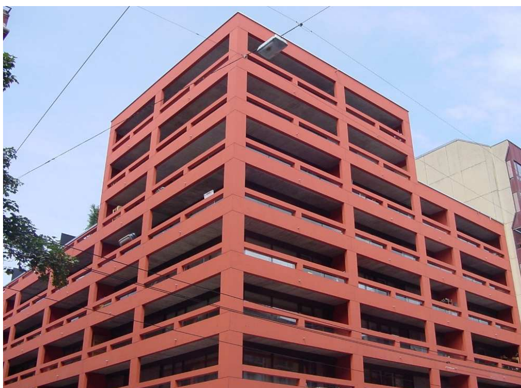
108 rue de Carouge (juin 2010) – 26 logements HBM
