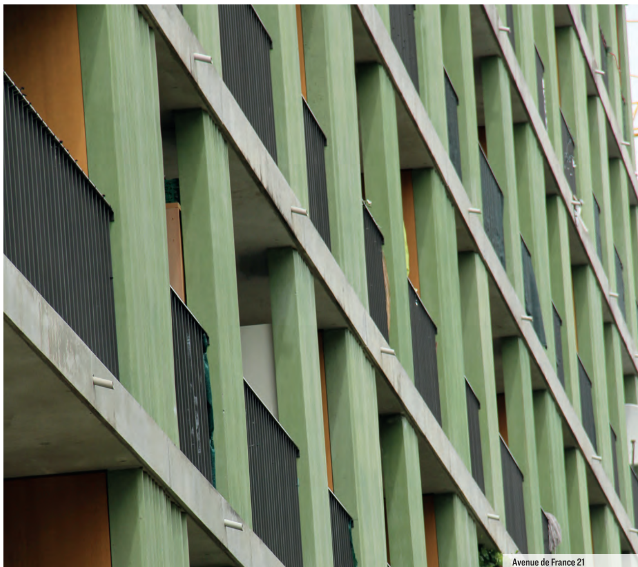
Avenue de France 21
